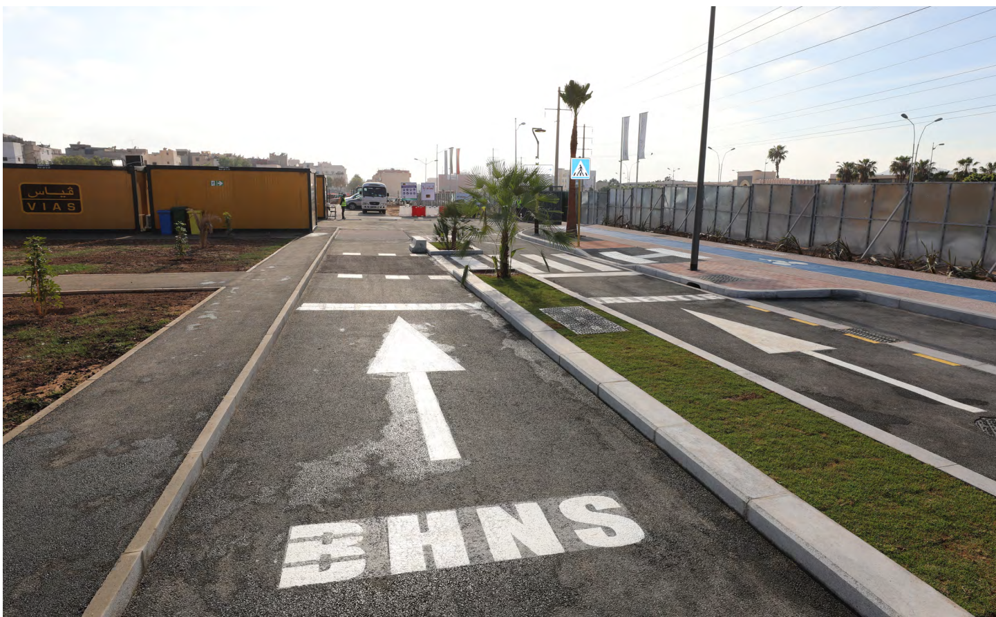
Figure 29. Réseau de BHNS à Agadir. Source : Commune d'Agadir (2022)
