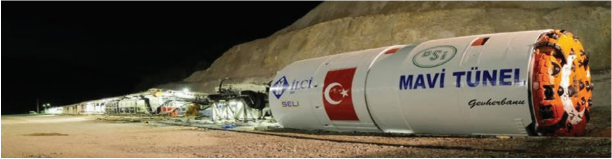
Fotoğraf : Konya Mavi Tünel içme suyu projesi
